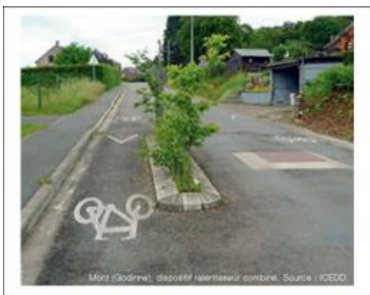
Végétalisation et passage sécurisé pour vélo,
