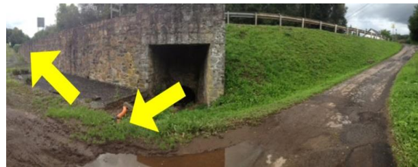
Entrée/sortie du pertuis existant passant sous la RN 62
