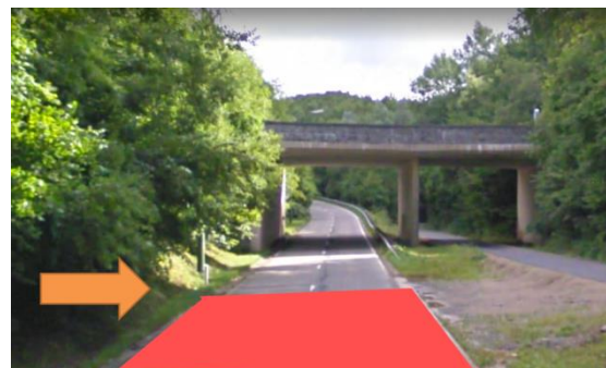
Traversée sur la route de Spa après le carrefour
